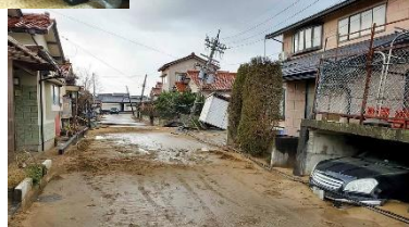
写3 西荒屋での液状化被害 噴出水で 一帯が水浸し by 神奈川新聞
