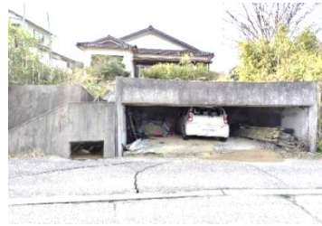
写5 手前の地盤隆起 建物沈下あり RC造は若干傾く
