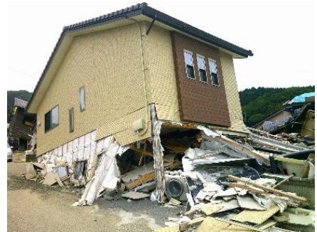
写8 2F建て家屋の1F崩壊、輪島 右；数少ない2000年基準の建物の被害下2；古い建物
