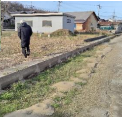
写1 側方流動 左; 地表に出現の側方流動滑線群(写真中央で水平方向に走るステップ)
