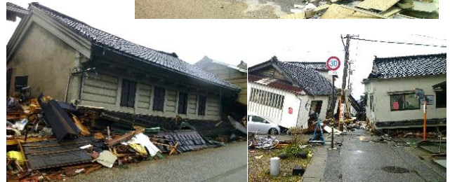
写8 2F建て家屋の1F崩壊、輪島 右；数少ない2000年基準の建物の被害下2；古い建物
