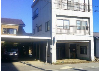
写 10 浸水後、泥かき出しの床 (左建物)と放置の床(右建物)
