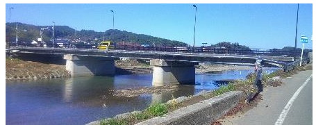
写8 上新橋にて流木が川を堰止め 上写10/24;枝等がひっかかり。 下写11/8;ではひっかかり材を 撤去。仮水道管の設置
