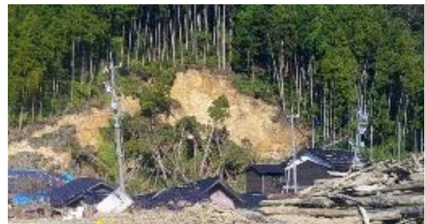
写4 町野町の内陸部；斜面崩壊と家屋被害
