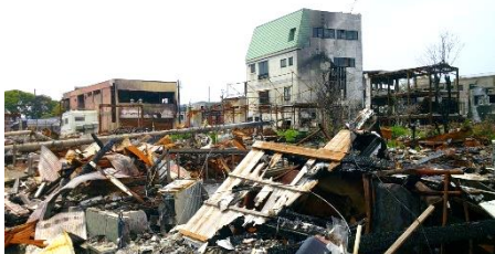
写6 輪島朝市通り一帯の火災現場上；火災建物下；道路が延焼北側境界左側建物は火災免れ
