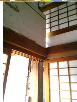
上; 香積台 鴨が柱から外れる 右; 山門、祖院対面、無被害 下左; 参道門柱が基礎石から抜る 下右; 祖院左側の回廊、倒壊寸前
