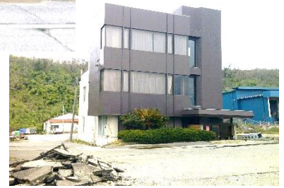
写5 手前の地盤隆起 建物沈下あり RC造は若干傾く
