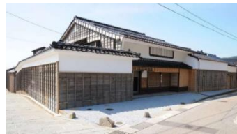
写 10 黒島角海家 左；倒壊前の雄姿 by 日経 Xtech 下：倒壊
