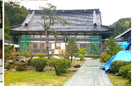
左; 祖院 写真で左隅沈下下; 香積台、祖院正面 右側に直角隣接、手前のブルートは崩壊した回廊
