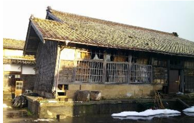
上；写真左手前側の基礎部に破損。建物傾斜
