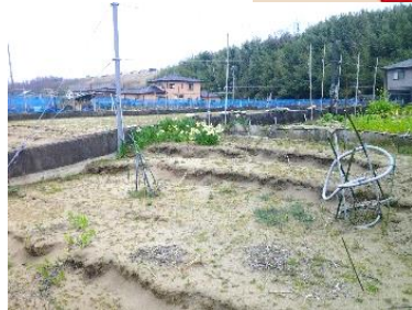
写1 側方流動左; 地表に出現の側方流動滑線群(写真中央で水平方向に走るステップ)
