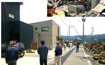
写6 輪島朝市通り一帯の火災現場 上；火災建物 下；道路が延焼北側境界左側建物は火災免れ
