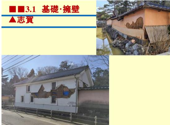
■■■土台・基礎部の崩壊が主因の上屋被害
