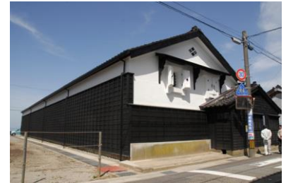
写真5 米騒動時の再建米蔵 HP より
