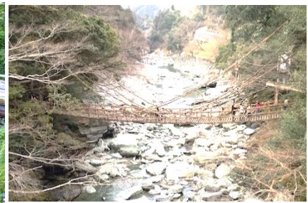
蔓橋；徳島三好市、修験道 全長 45m、幅 2m、高さ 14m 材はソウカカズラ
