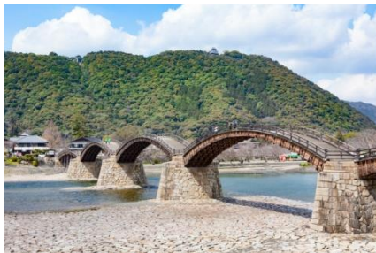
錦帯橋；山陽道、岩国市 全長 193.3m、幅 5m、4脚5パソ 石積み橋脚
