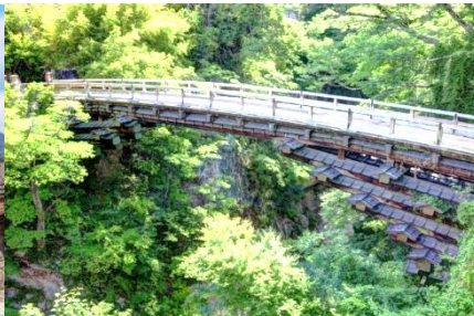
猿橋；甲州道、大月市 全長 30.9m、幅 3.3m、高さ 31m 4層刎材
