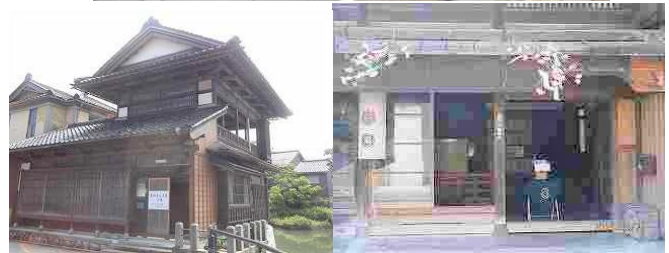
写5 旧宮崎酒造、四川亭、城戸家
