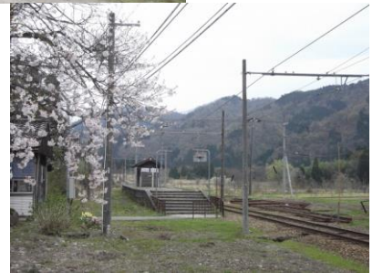
横江駅 上：駅舎、下：駅構内
