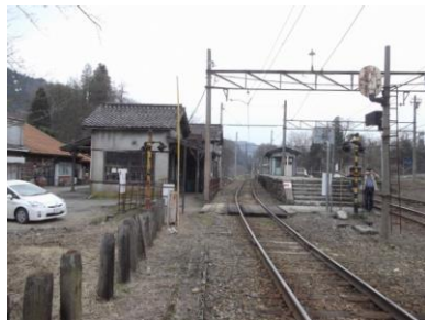
有峰口駅 上：駅舎、下：駅構内
