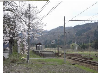
横江駅 上：駅舎、下：駅構内
