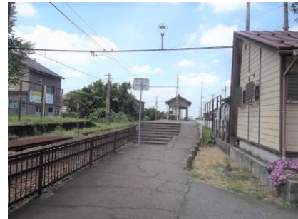
上滝駅 上：駅舎、下：駅構内
