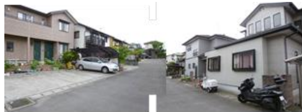
写真2 非倒壊の住宅群地区(益城)
