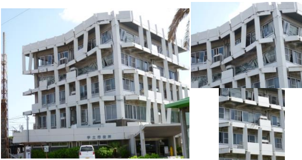
写真8 宇土市役所の倒壊
