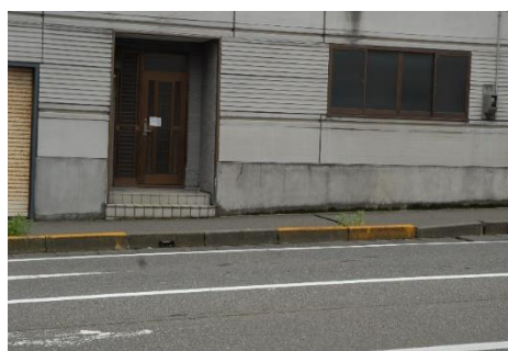
写真1, 2 2007年新潟県中越沖地震（柏崎市）
