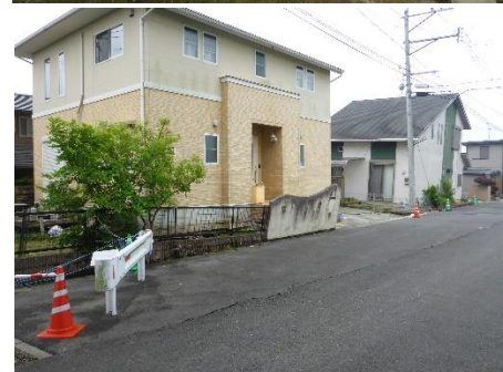
写真7, 8 2016年熊本地震(熊本市南区)
