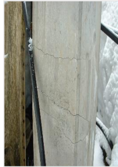
図7 せん断した柱脚
