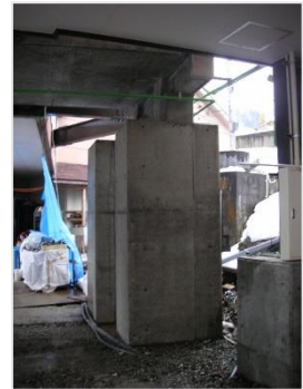
図8 補強した柱脚
