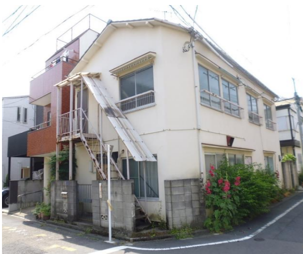
図5 古い木造アパートなどでは大きな地震の揺れで倒壊の可能性があること、特に一階がつぶれる事例が多いということを居住者や居住を検討している人に周知する必要があるのではないかと
