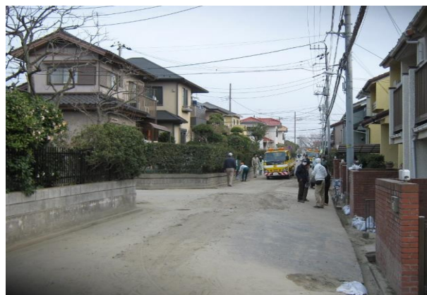
図3 2011年東日本大震災における液状化で沈下、傾斜が起こった住宅地。船原英樹氏撮影
